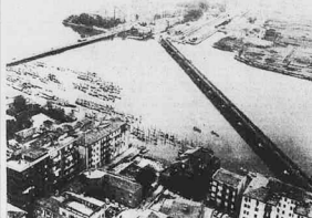
Cominciò il ponte di Chioggia. In alto: il cantiere per il nuovo ponte di Chioggia
